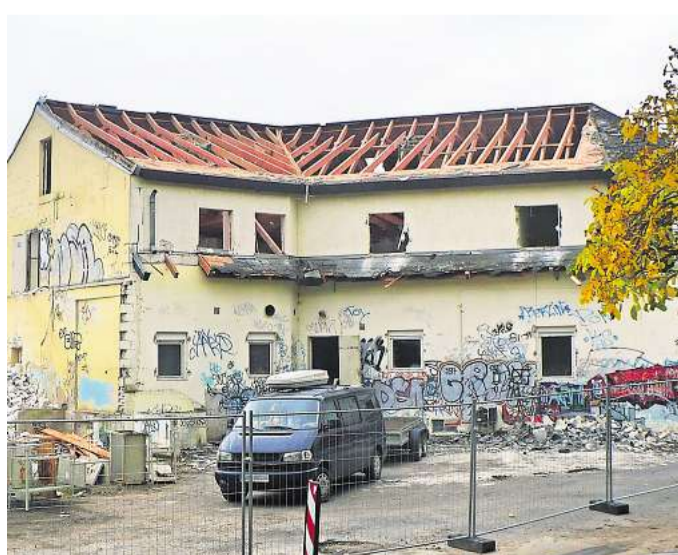
Der „Nussbaum“ wird gerade entkernt. FOTO: ROBERT TIESLER
